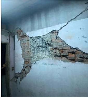
圖 19 中度破壞程度之案例照片
