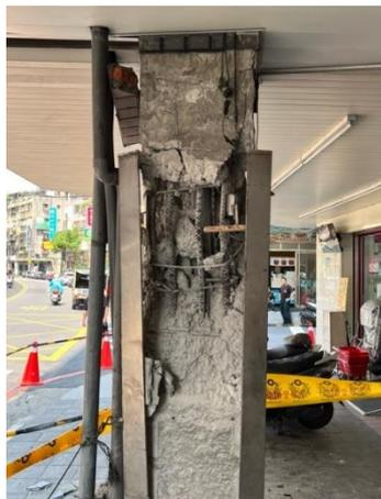
圖 20 重度破壞程度之案例照片
