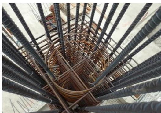
系統化、工業化「建築安全履歷 Alfa Safe 鋼筋系統化工法」超越現有傳統工法，經國家地震工程研究中心實體試驗證明，其抗震韌性有效大幅提升，完整發揮建築耐震韌性、確保設計與施工相符，讓民眾居住安全確實獲得保障。
