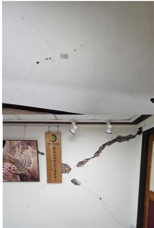
圖 13 0403 地震行政大樓主體柱樑結構無受損，僅隔間磚牆裂紋破壞(以三樓及五樓為例)(資料來源: 政治大學總務處)
