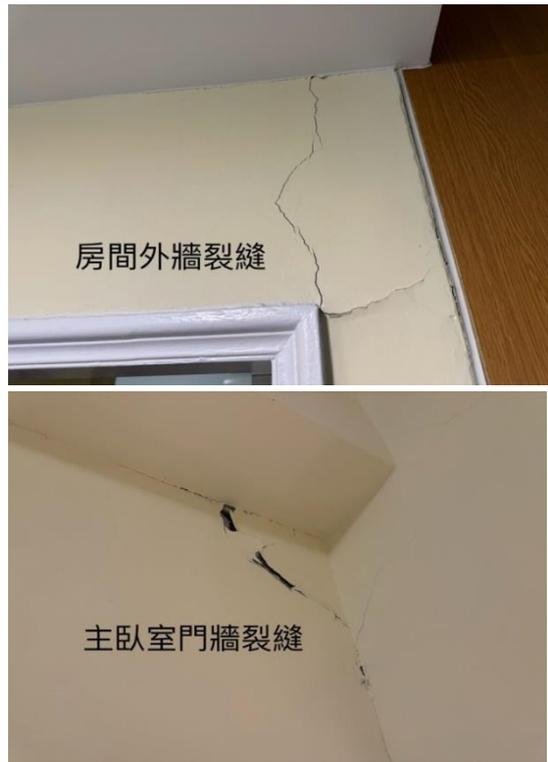
圖 18 輕度破壞程度之案例照片
