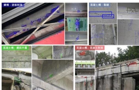
圖 5 自動識別災損評估系統之照片
