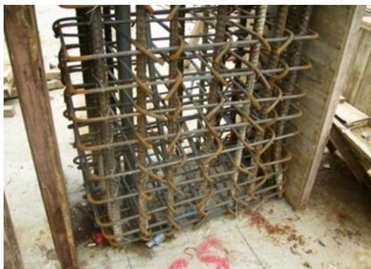
「傳統工法」柱箍繫筋組件眾多，綁紮繁複；施工品質控管不易，疏漏時
